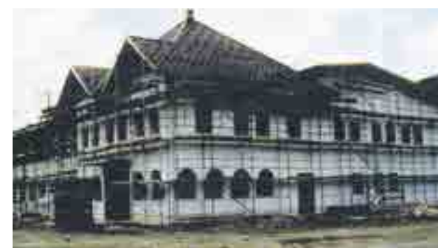
Die Schaukäserei ist noch im Bau.
