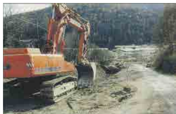
Schweres Arbeitsgerät wurde aufgeföhrt, um das Bett des Klammschlüsselbachs in Innichen zu verlegen.
